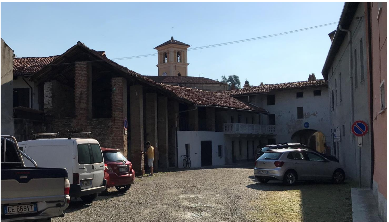
Figura 7 – Edificio oggetto d'intervento, lato cortile interno
