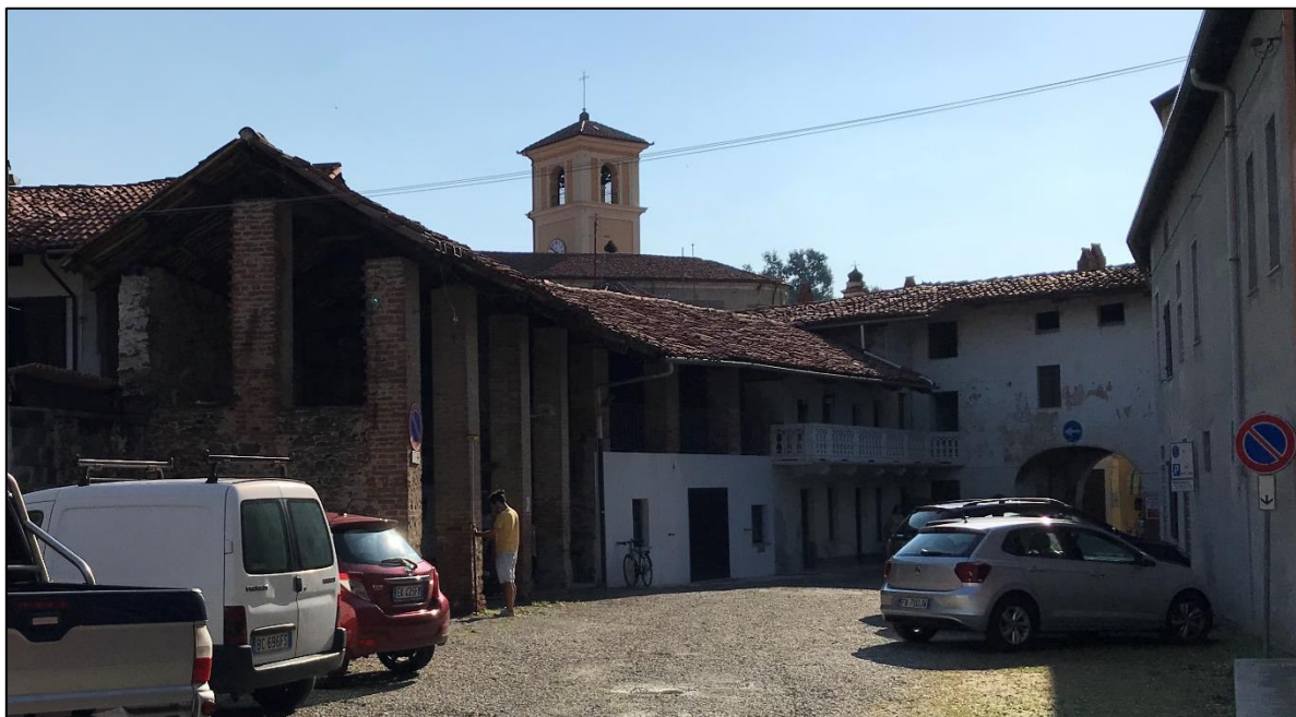
Figura 2 Edificio oggetto d'intervento, lato cortile interno
