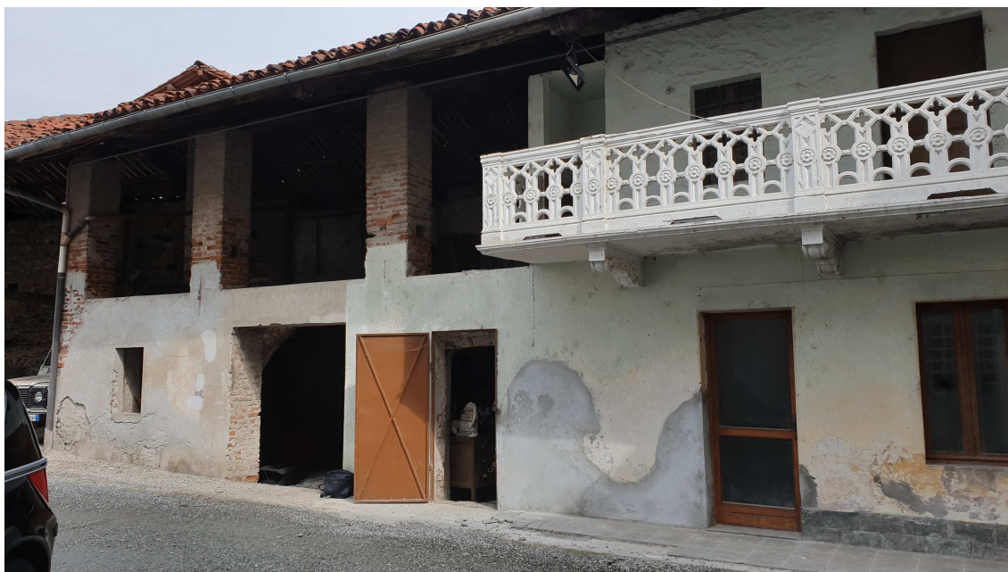
Vista del fronte Sud della porzione oggetto di intervento
