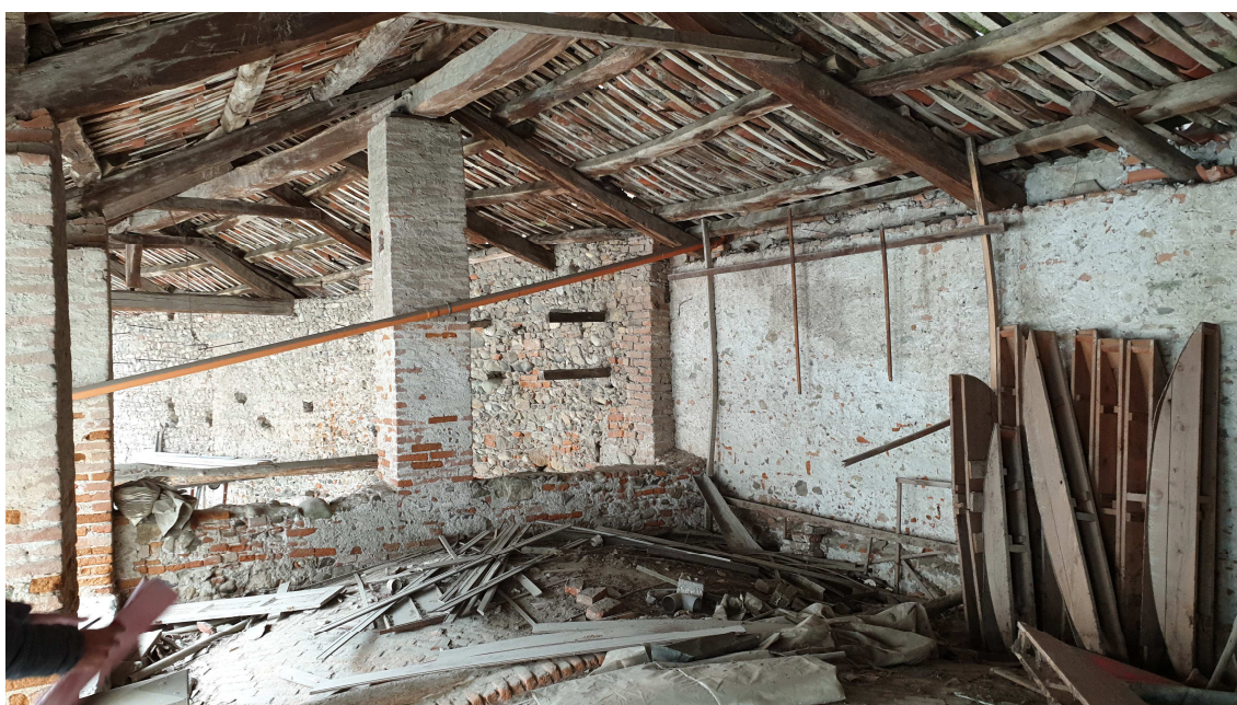
Vista della travata a nudo tetto al piano primo e sullo sfondo il muro in pietra oggetto di innalzamento
