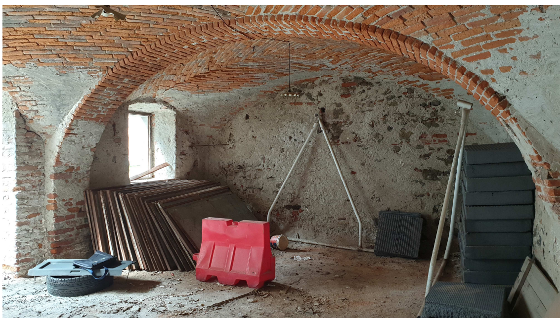
Vista interna del locale di deposito
