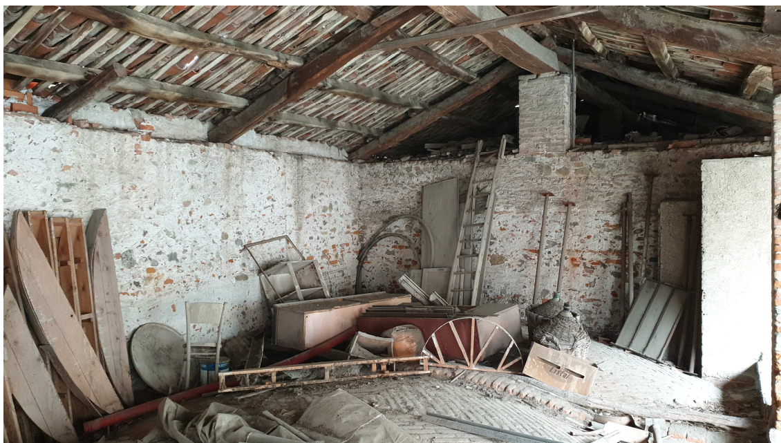
Vista della travata a nudo tetto al piano primo oggetto di consolidamento
